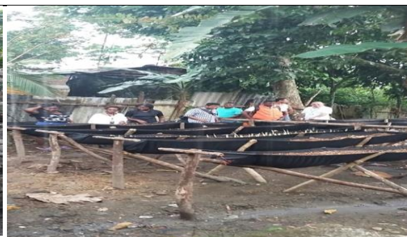
Foto 2: Adecuación de las Huertas
